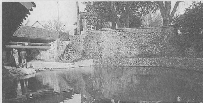
On distingue sous le pont, la saignée centrale du ravier, et les fameuses cages à pierres, devant le mur d'un riverain.
