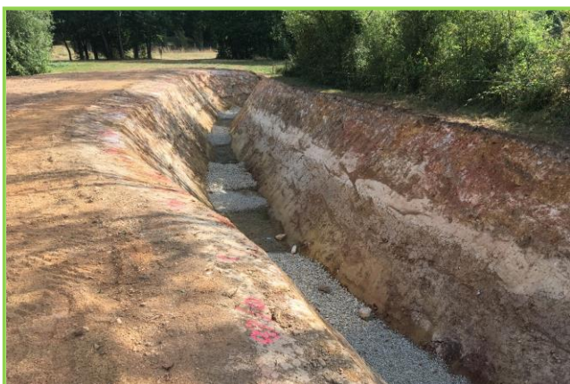
Création d'un lit sur 300 m et pose de géotextile (Juillet 2019)
