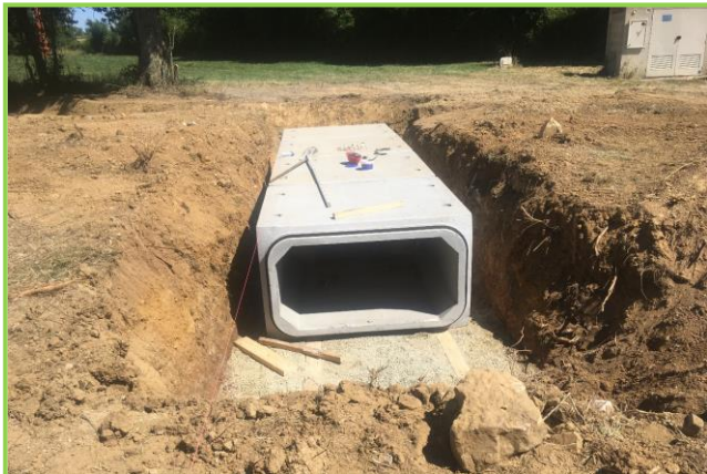
Installation de 2 pont-cadres (Juillet 2019)
