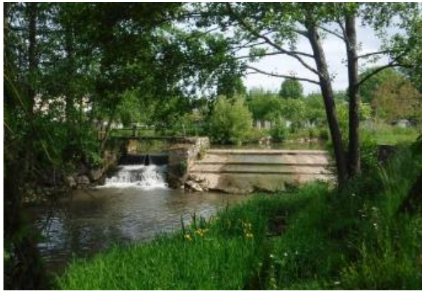
Vue aval de l'ouvrage avant travaux
