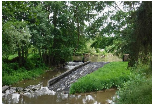
Vue aval de l'ouvrage après travaux (Photomontage)
