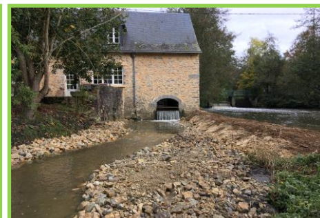
Travaux connexes à Montguyon
