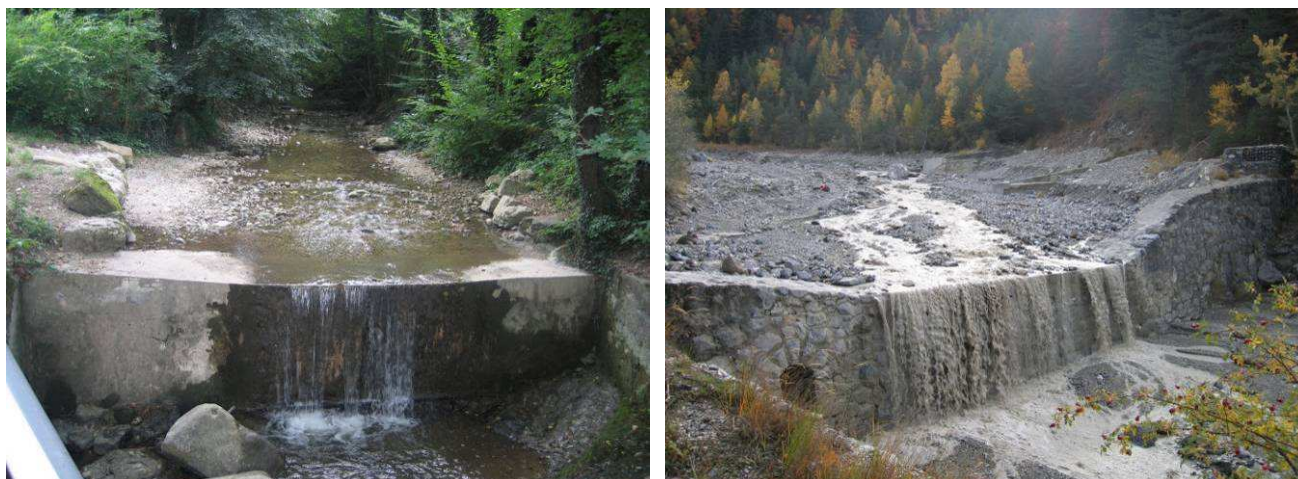
Figure 1 : exemples de seuils en grande partie transparents vis à vis du débit solide grossier (photos Malavoi)
